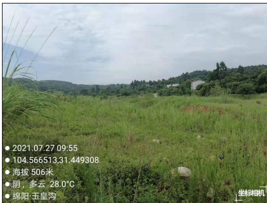
图 3-1 弃渣场现状照片
